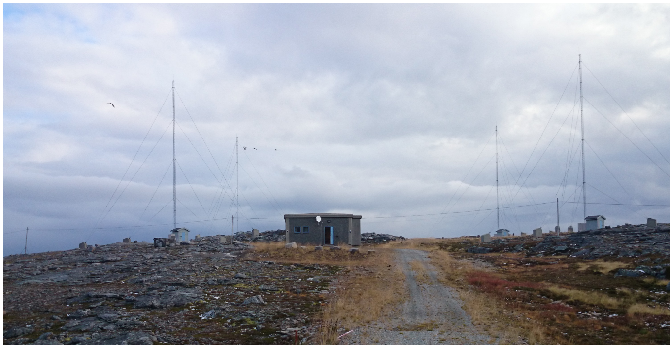
Hammerfest/Middagsfjellet. Sendermaster for MF/HF 1000W radiosendere. Foto: Telenor Kystradio
